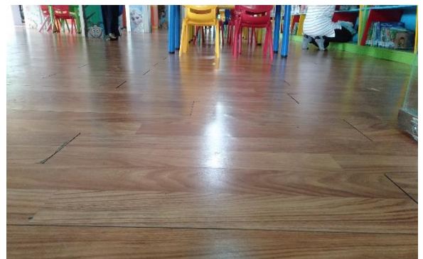
Gambar 4. 5 Lantai setelah pengecoran
