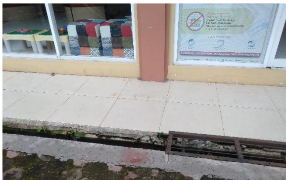
Gambar 4. 4 Bagian luar lantai ruang layanan anak
