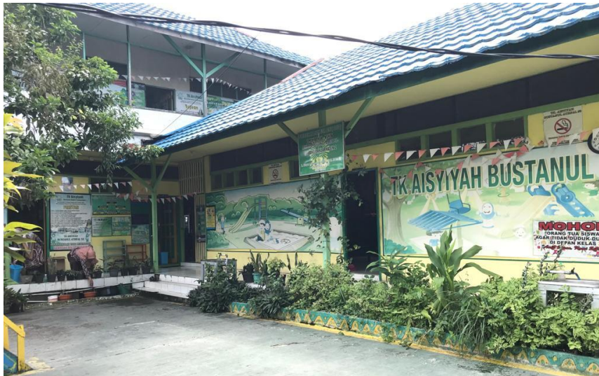
Bangunan Lembaga TK Aisyiyah Bustanul Athfal 32 Banjarmasin
