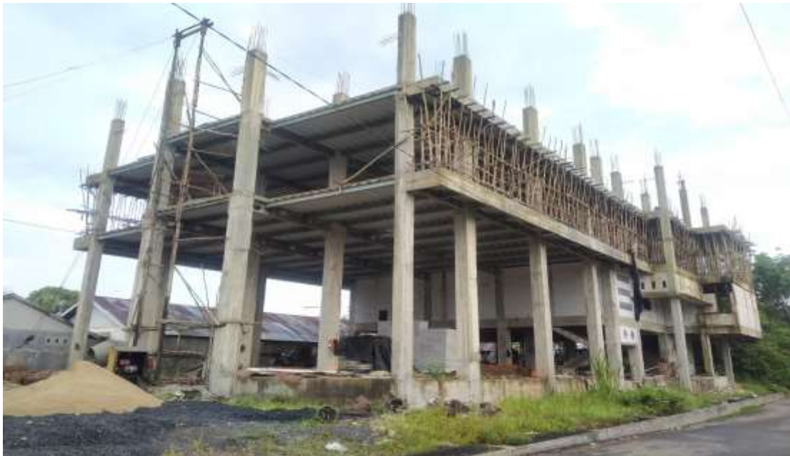
Rumah Tahfidz Anwarul Mustofa Kalimantan Selatan (Masih Proses Pembangunan)
