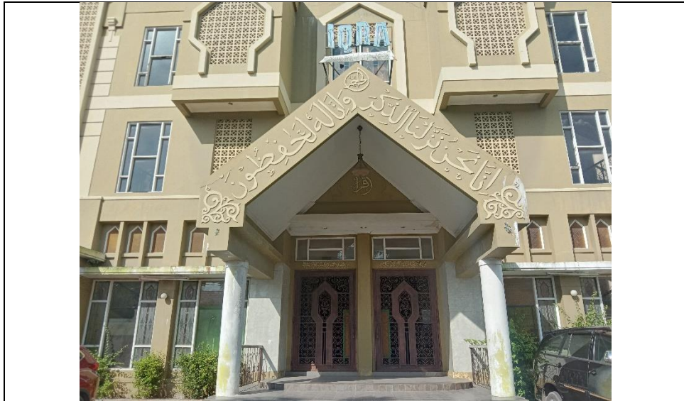
Gedung TKA/TPA/TQA Unit 001 Iqra Mahligai Al-Qur'an Banjarmasin Tampak dari Depan
