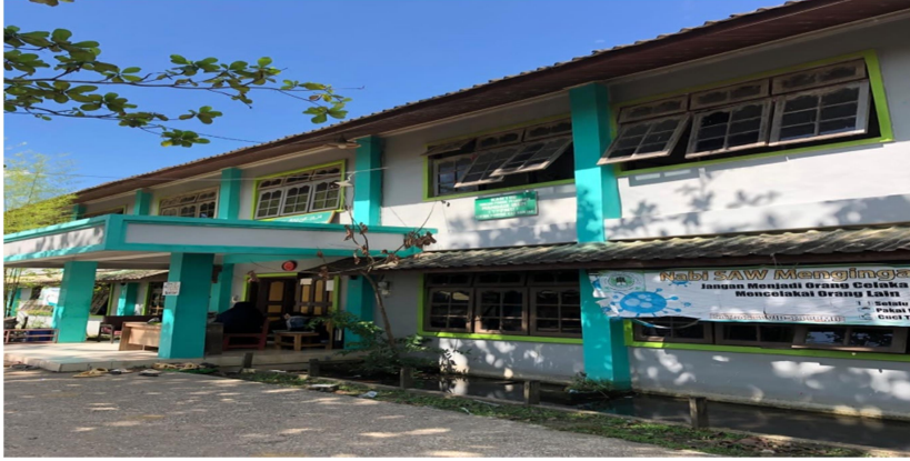
الصورة ١: المبنى في معهد منبع العلوم للبنات بمنطقة بنجر.
