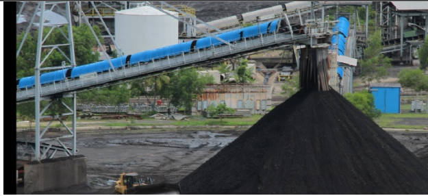
Room (tempat penyimpanan batubara)
