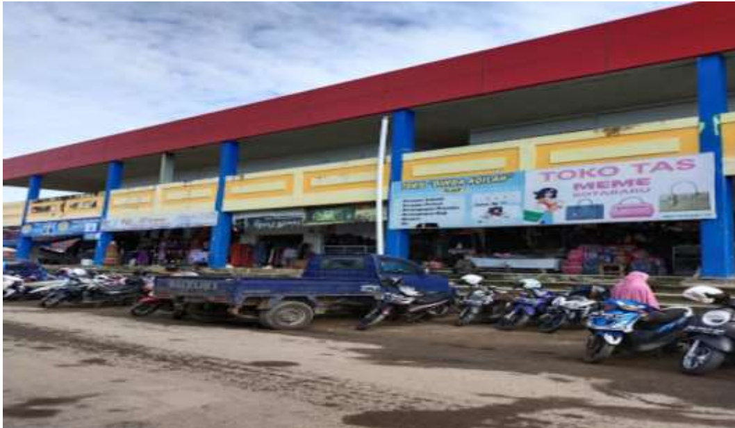
Foto Pasar Kemakmuran Blok B dan F Kabupaten Kotabaru Setelah Dilakukannya Perbaikan
