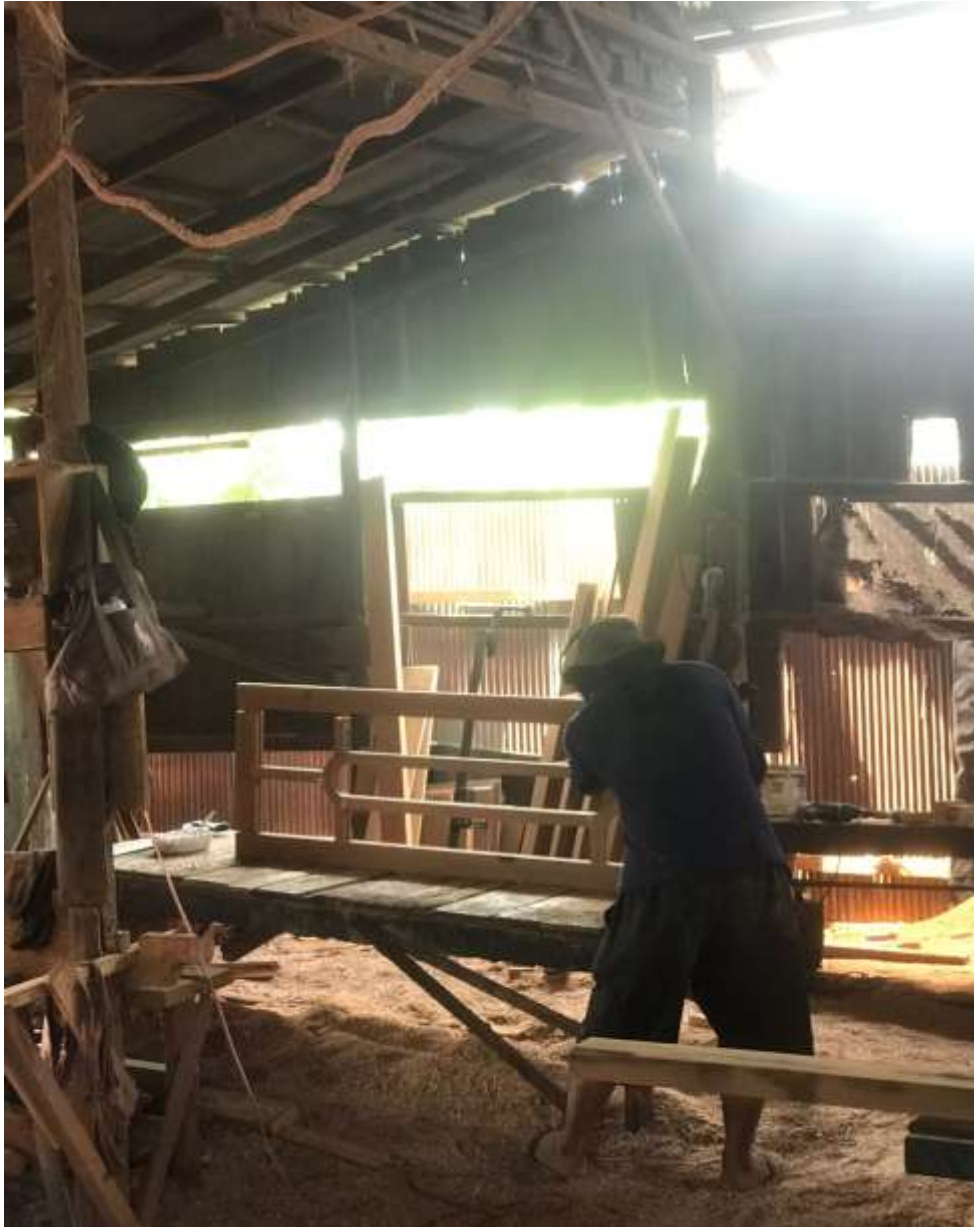
Gambar II Proses pemasangan kerangka jendela
