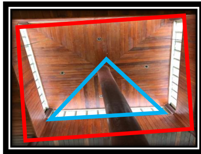
Gambar 4.6 Plafon Masjid Syuhada Balangan
