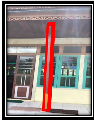
Gambar 4.12 Tiang pada Teras Masjid Syuhada Balangan
