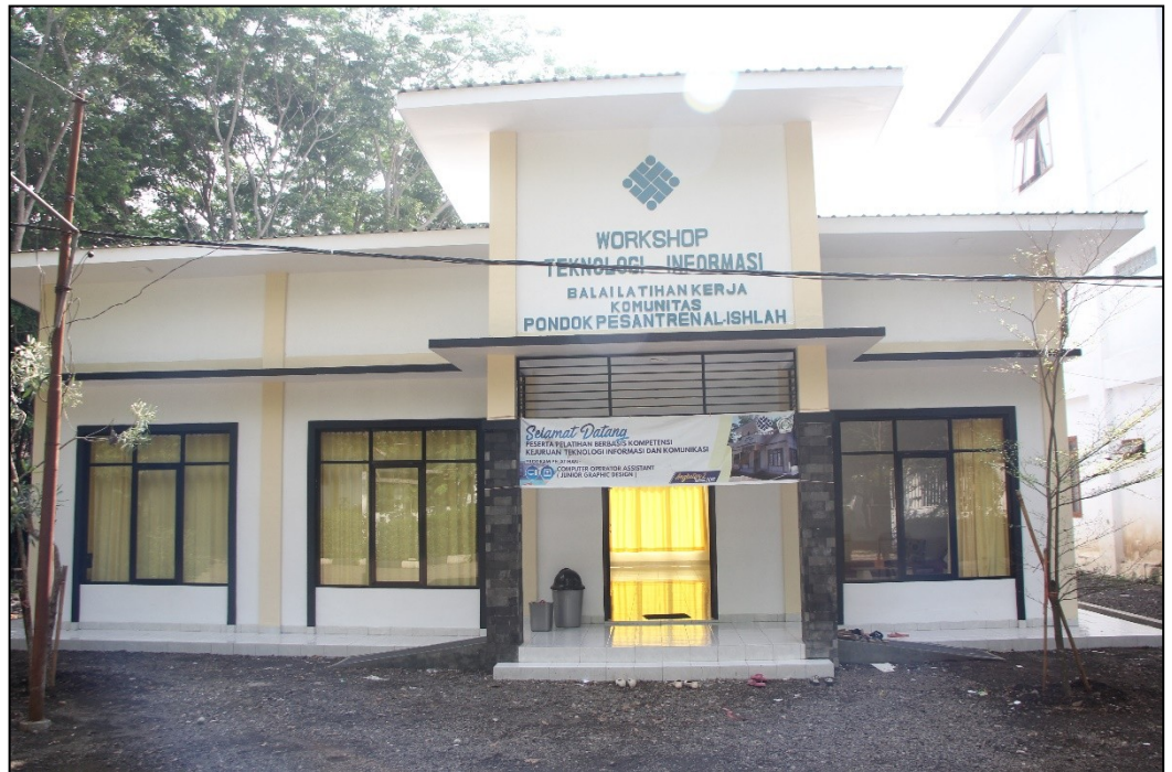
Gambar 4. 12 Gedung Balai Latihan Kerja Pondok Pesantren Al-Ishlah
