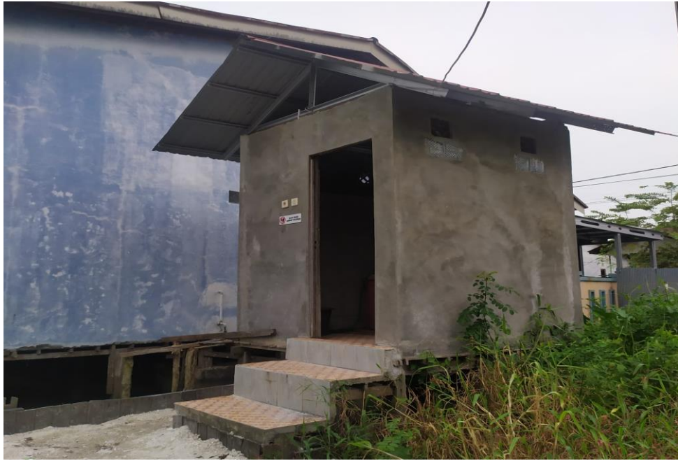
Tempat WC TPA Darul Falah
