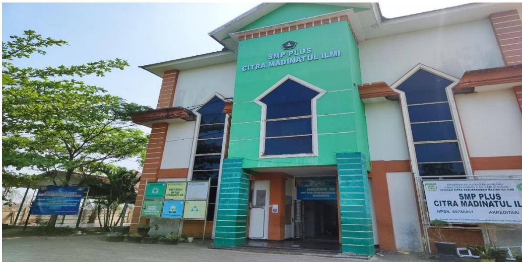
Gambar Bangunan Sekolah
