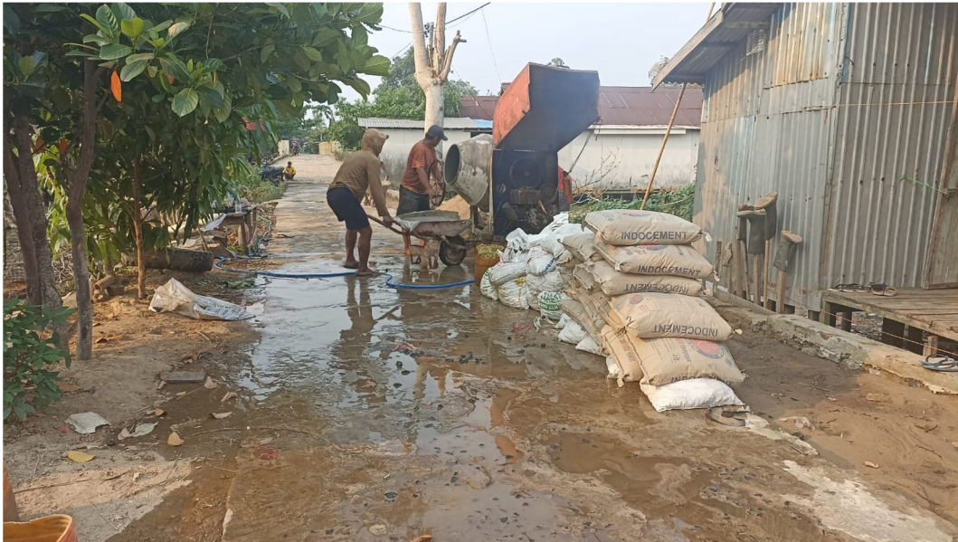
Gambar 4. 2 Proses Pengerjaan Perbaikan Jalan Di Desa Kuripan
