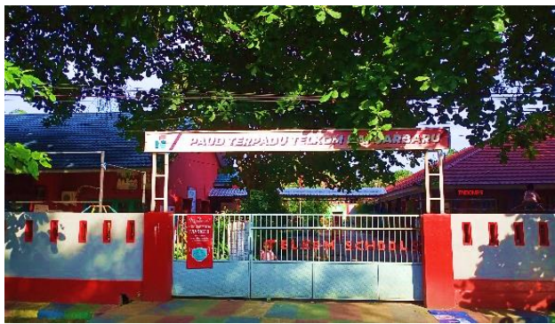
Gambar 4.1. Gedung PAUD Telkom Banjarbaru (DLF.1) 1
