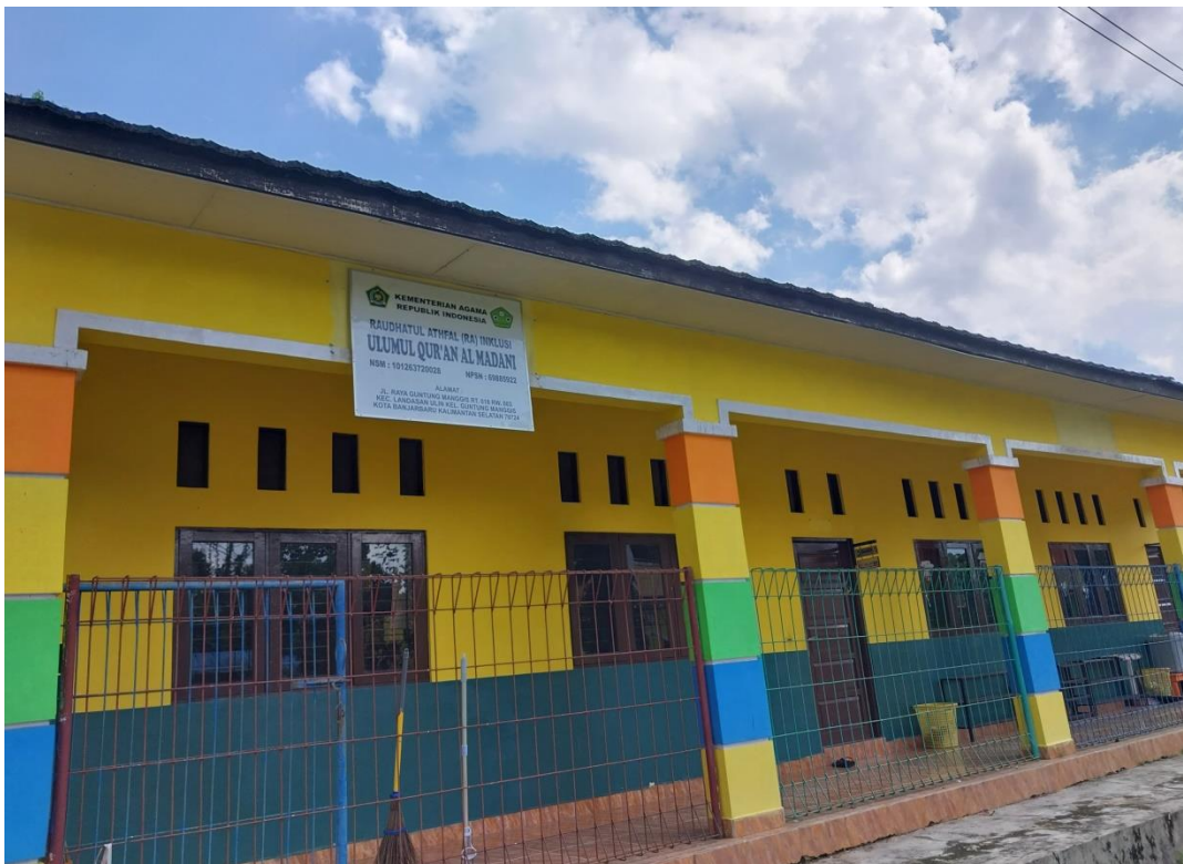
Bangunan Depan Kelas RA Ulumul Qur'an Al Madani
