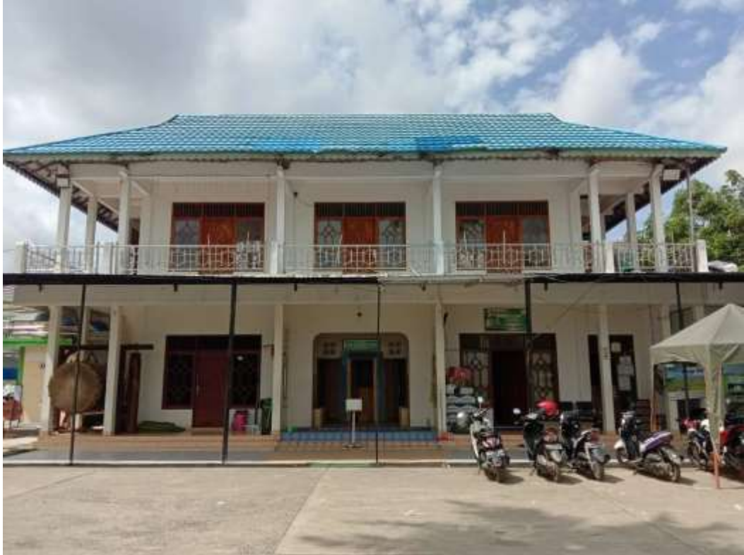
Gambar Ruang Kesekretariatan dan Aula Masjid At-Taqwa Binuang
