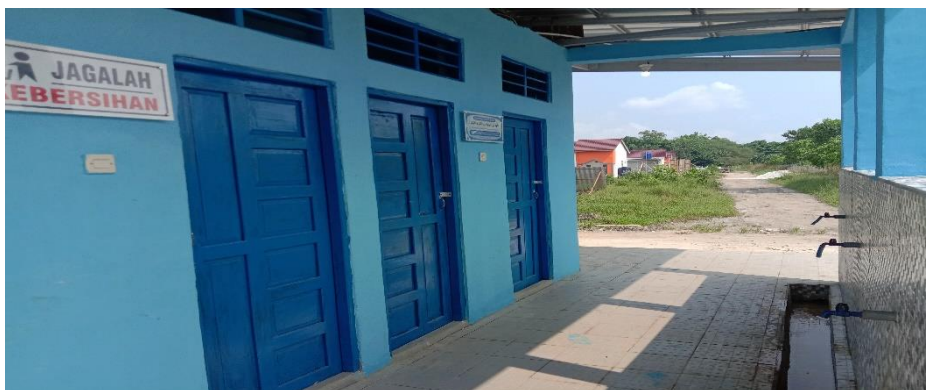
Tempat Wudhu dan Water Closet
