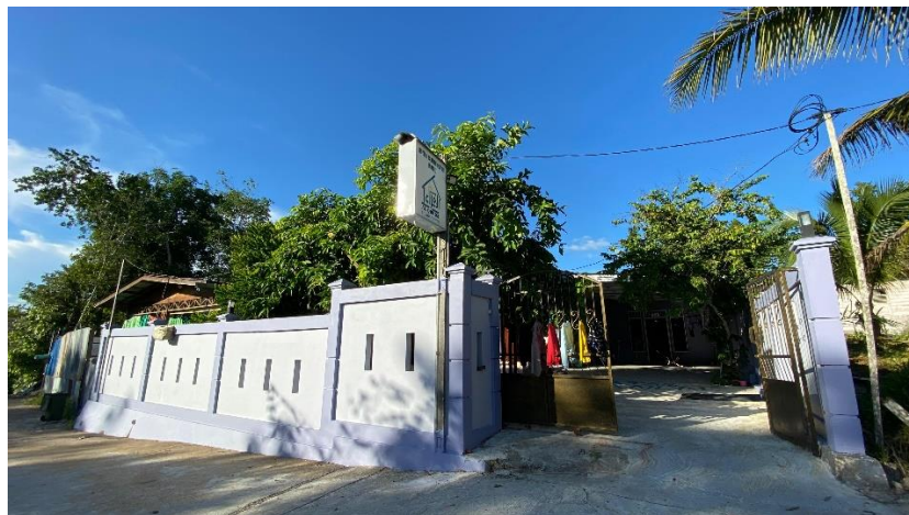
Gambar 5.2 Rumah Tahfidz Al-Qurra' Tampak dari Luar
