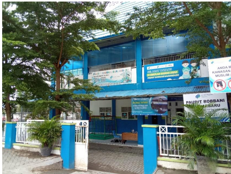
Gambar 4.1 Gedung PAUDIT Robbani Banjarbaru (DLF) 46
