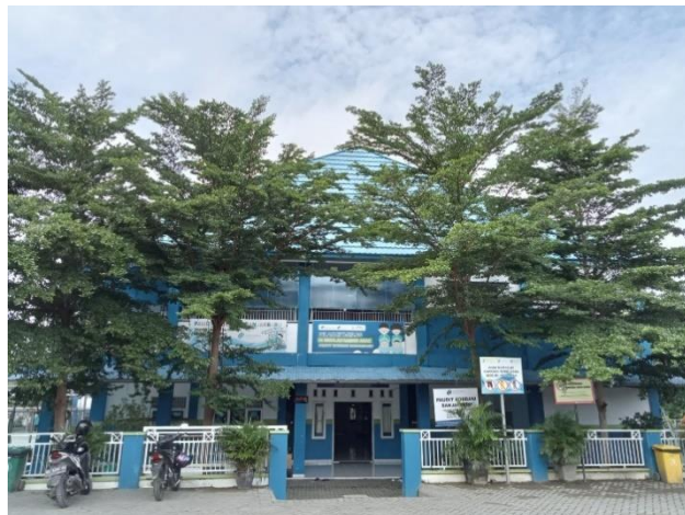
Gambar 4.1. Gedung PAUDIT Robbani Banjarbaru (CDFGS.4.1 ) 34
