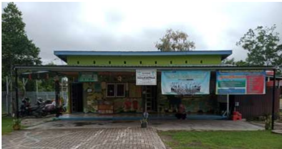
Gambar 4.1 Bangunan Sekolah PAUD Alam Darunnajah (DLF.1) 56
