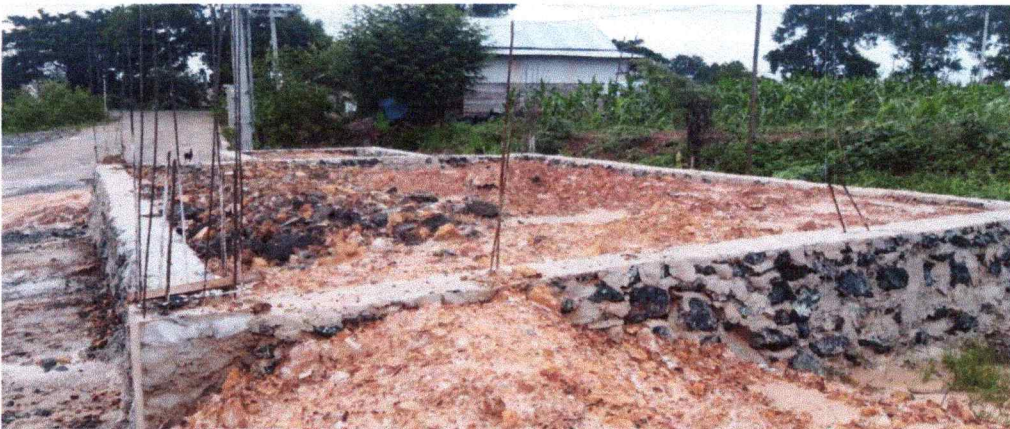
Gambar 4.5. Progres Pembangunan Musholla
