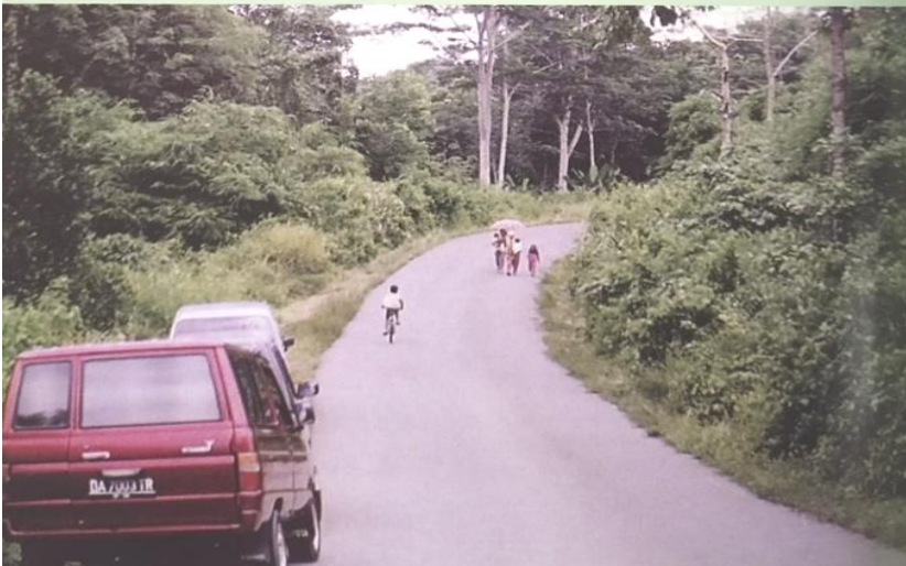
Gambar 87. Proyek jalan dan jembatan yang dibangun di era Gubernur H.M. Sjachriel Darham. Sumber: buku H.M. Sjachriel Darham.
