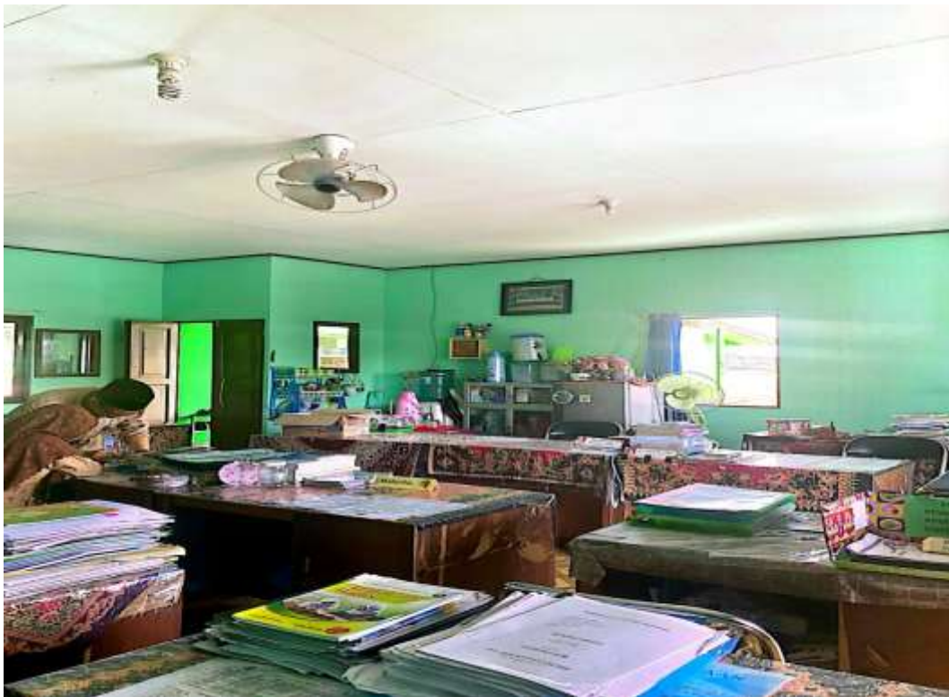
Kondisi kantor MTs Inayatuththalibin Banjarmasin
