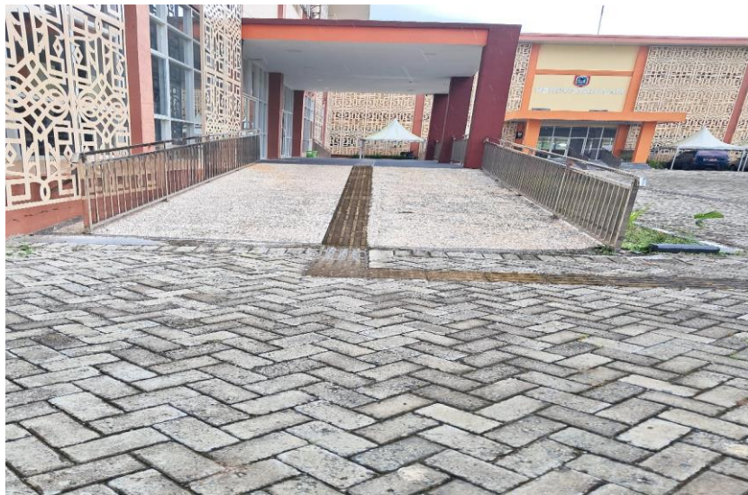
Gambar 1 ramp lantai pada gedung perpustakaan disabilitas yang ada di Dinas Perpustakaan dan Kearsipan Provinsi Kalimantan Selatan
