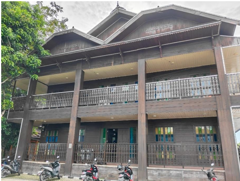
Tampak Depan Pada Rumah Anno 1925.
