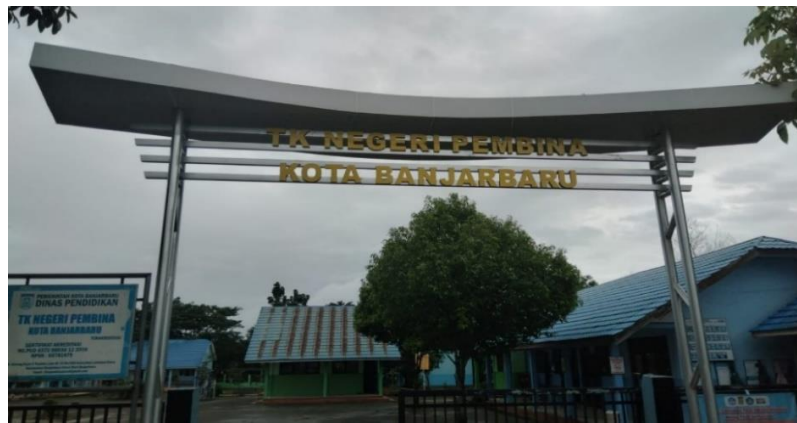
Gambar 4.1 Bangunan Sekolah TK Negeri Pembina Kota Banjarbaru (CDFSP1.1) 44
