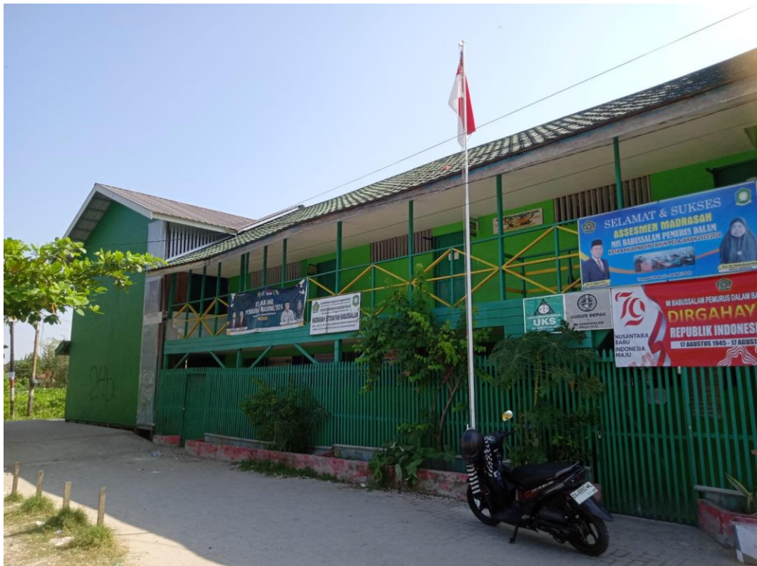
Gambar 5. Dokumentasi sekolah dan fasilitas yang ada
