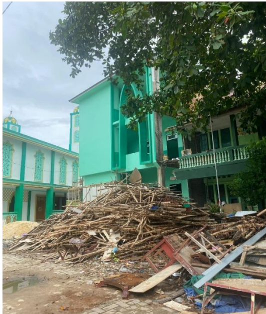
Proses pembangunan Madrasah Aliyah Hidayatullah Martapura
