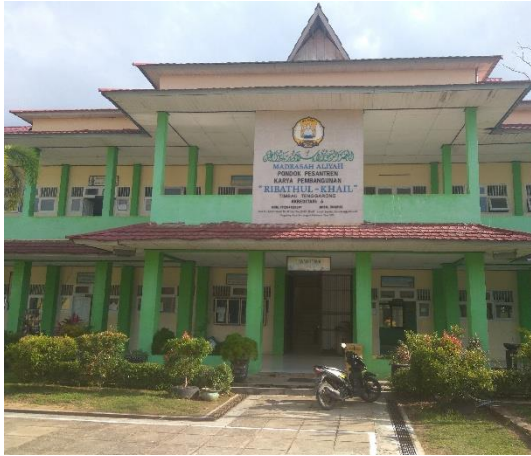
Gedung PPKP Ribathul Khail Tenggarong
