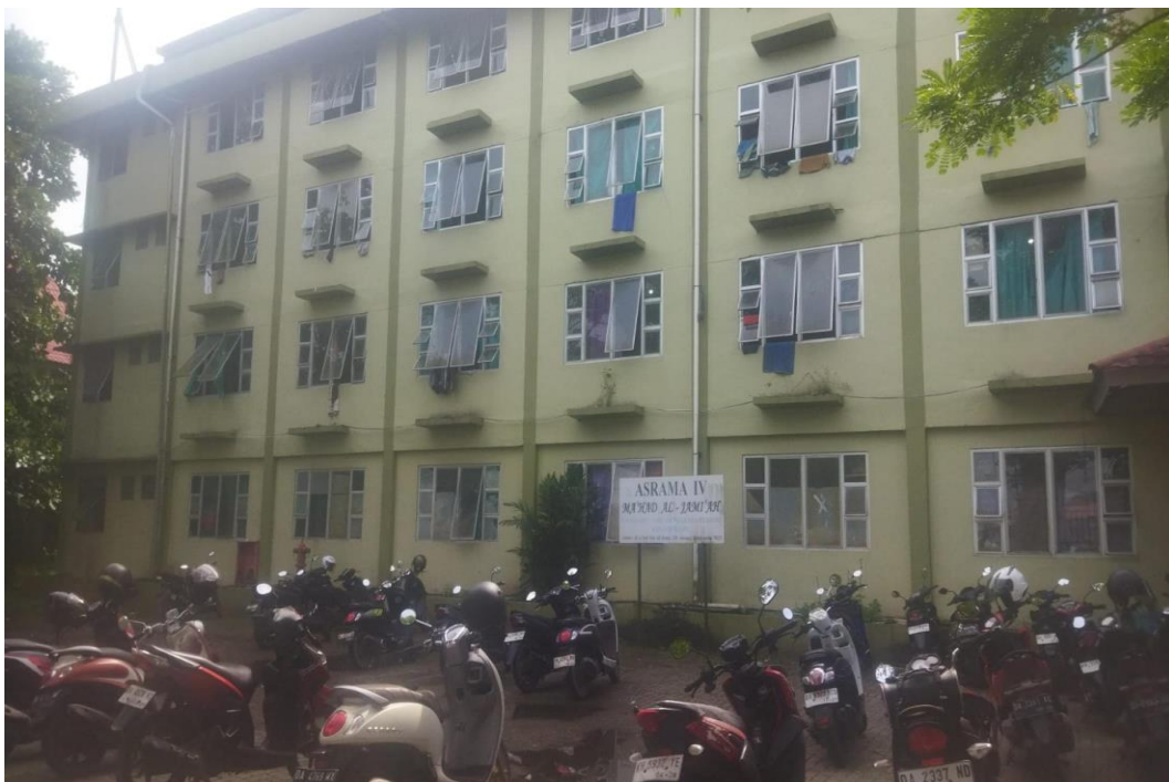
Dokumentasi Asrama IV Putera tampak dari luar
