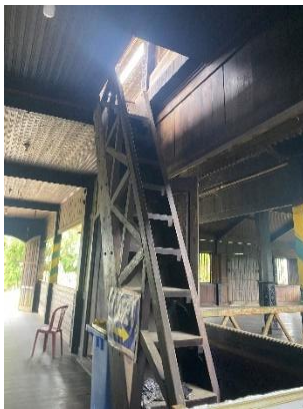
Gambar 4. 10 Tangga untuk ke lantai atas Balai Rumbang
