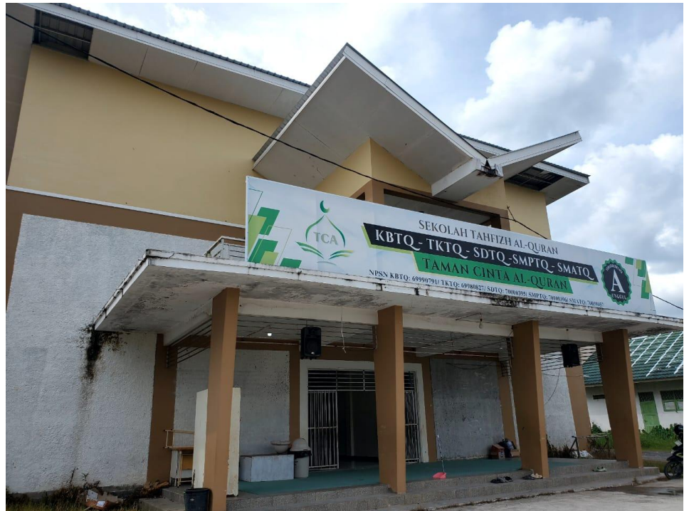
Gambar gedung SDTO Taman Cinta Al-Qur'an Barito Kuala
