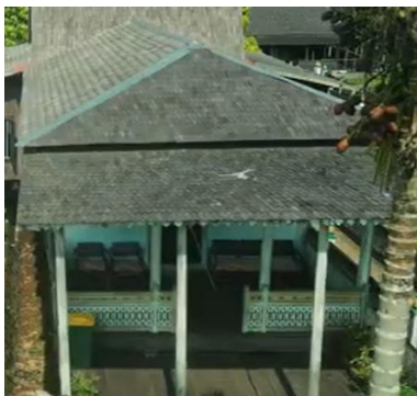
Gambar 4.15 Atap Pelana pada Rumah Adat Gajah Baliku
