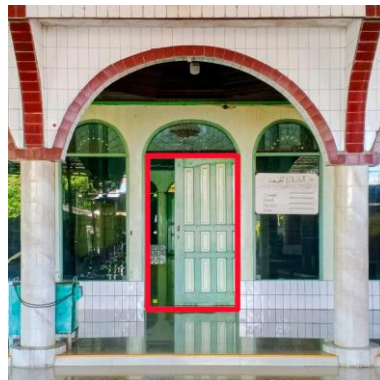
Gambar 4.47 Pintu Geser Ruang Utama Masjid
