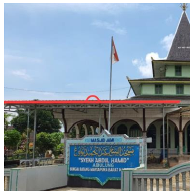
Gambar 4.30 Bagian Tepi Atap Kanopi
