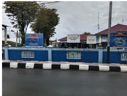
Gambar 4.1. Gedung Depan Sekolah TK Angkasa I Lanud Sjamsudin Noor (DLFGS.1.1) 1
