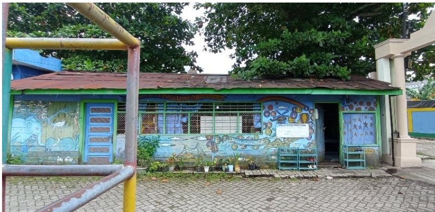
Gambar 4.1 Gedung TK Pertiwi 1 Banjarmasin
