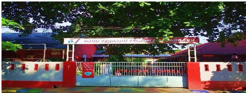
Gambar 4.1. Gedung PAUD Telkom Banjarbaru (CDFGS.4.1) 56
