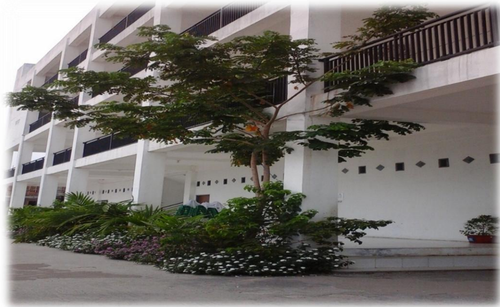
Tampak dari belakang bangunan SMK Unggulan Husada
