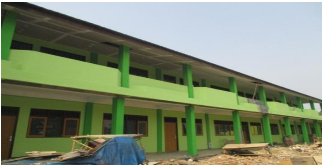
GAMBAR 4.4 PEMBANGUNAN RUANG KELAS BARU (RKB) PONDOK PESANTREN DARUL HIJRAH PUTERI
