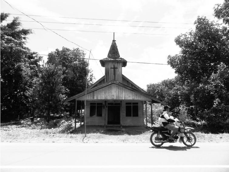
Gambar 3. Gereja di Jalan Trans Kalimantan Kacamatan Basarang
