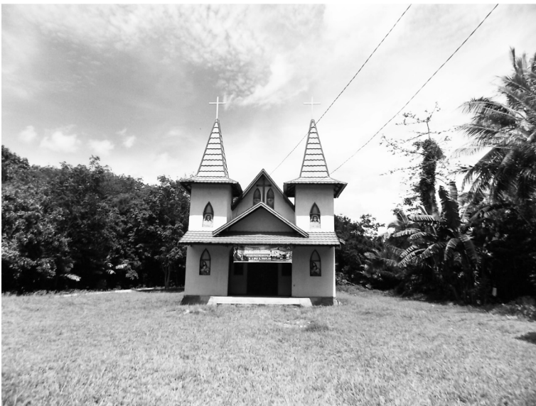
Gambar 2. Gereja di Jalan Trans Kalimantan Kacamatan Basarang
