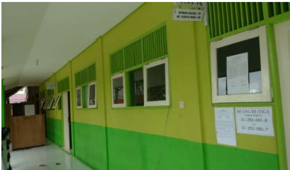
Gambar 16. Gedung SDN Sungai Miai 5 Banjarmasin
