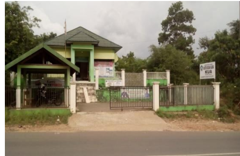
Gambar: Kantor Urusan Agama (KUA) Kecamatan Cempaka Bangunan dijadikan sebagai tempat kerja bagi para Pengawas PAI Kota Banjarbaru (tampak depan)
