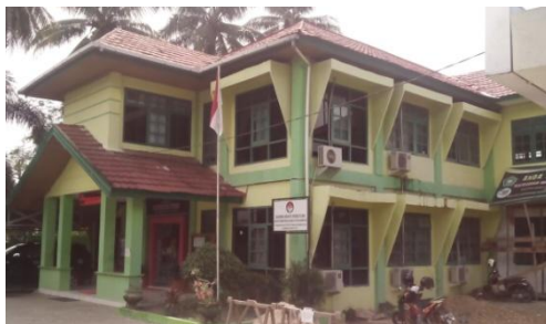
Gambar: Kantor Kementerian Agama Kota Banjarbaru Tahun 2017 (tampak samping kiri)
