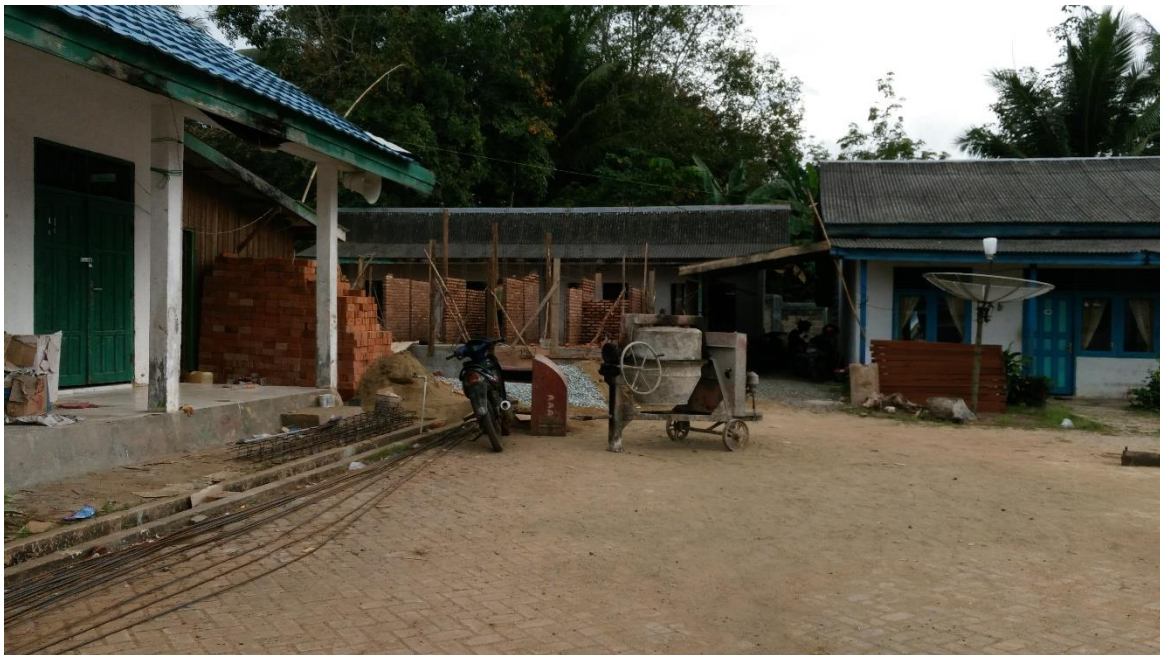
Proses pembangunan jamban di Madrasah Aliyah Nurul Hijrah
